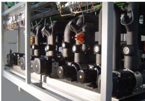
In das Gerät integrierte Verbraucherkreisläufe mit jeweils eigener Pumpe Into the unit integrated secondary circuits with a pump each
